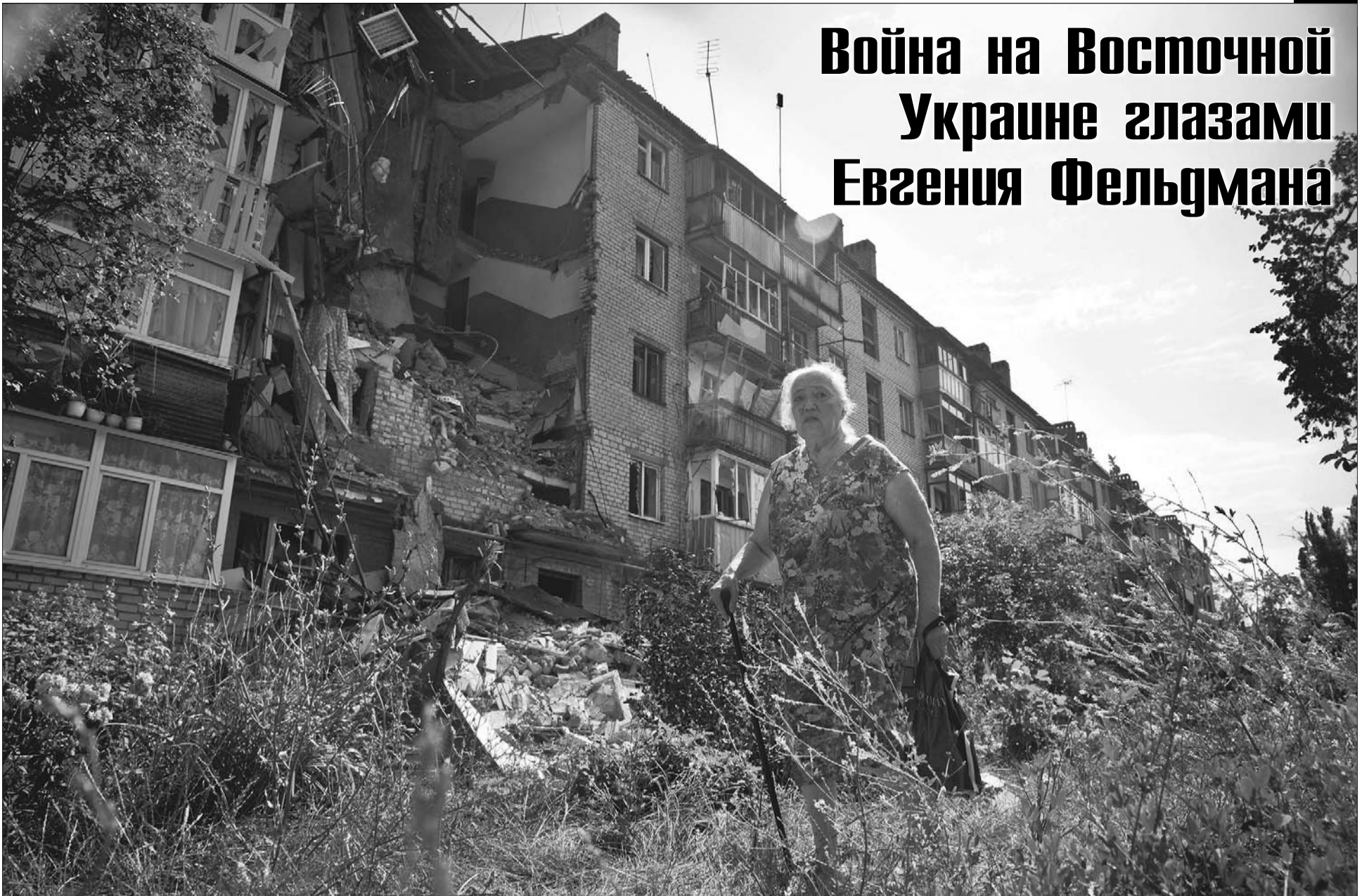
Разрушенный подъезд дома в Славянске
