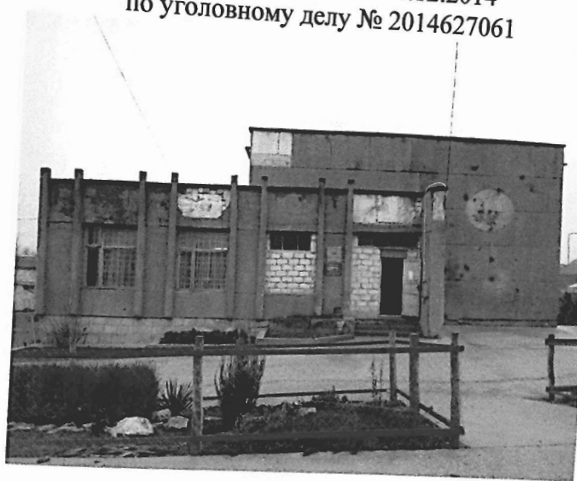
Фото № 1: общий вид д. 4 по ул. Подгорная в с. Железнодорожное Бахчисарайского района Республики Крым
