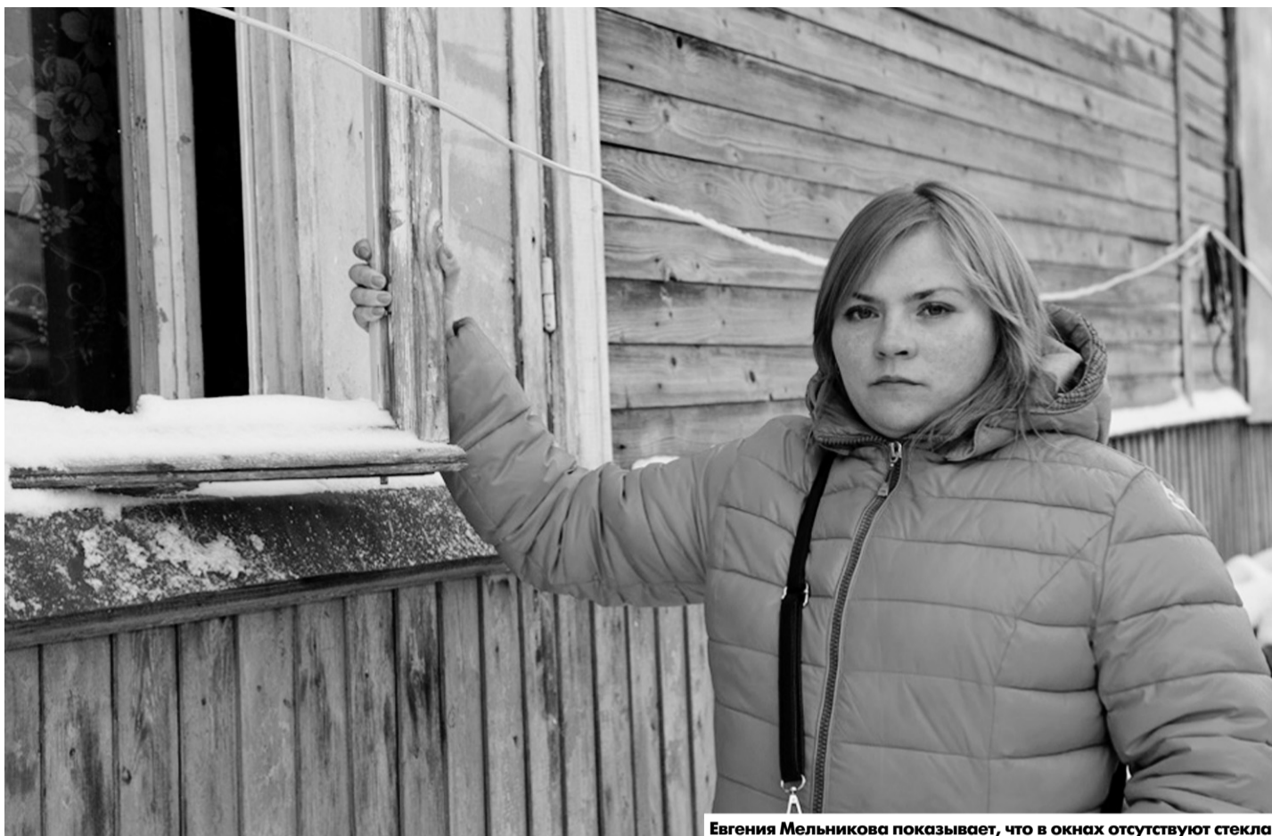
Евгения Мельникова показывает, что в окнах отсутствуют стекла
