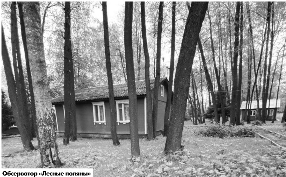
Обсерватор «Лесные поляны»
